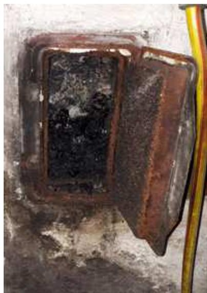
Beim Eintreffen am Einsatzort war der Kaminbrand bereits verloschen, die Wände im Bereich des Kamins des Festbrennstoffkessels aber doch noch sehr heiß. Der Kessel wurde vom Hausbesitzer schon außer Betrieb genommen. Bei einer Kontrolle des Kamins bei den Putzöffnungen wurde ein ca. 4 cm starker Belag festgestellt.
